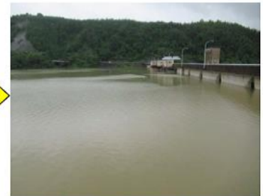
洪水時最高水位に近く貯水池の状況 (7月6日17時頃 EL.150.81m(上昇中))
